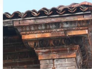
I canali di gronda, già descritti nella manualistica rinascimentale, servono a ricevere le acque raccolte dalla falda e a convogliarle fino ai pluviali o alle bocche di scarico.
