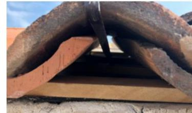
Un altro sistema utilizzato per evitare lo slittamento è quello di interporre tra il primo strato e il secondo superiore, a filo gronda, una piccola parte di coppo, in modo da rialzare la prima fila.
